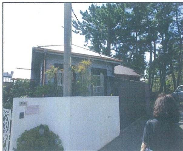
道路側からの外観
