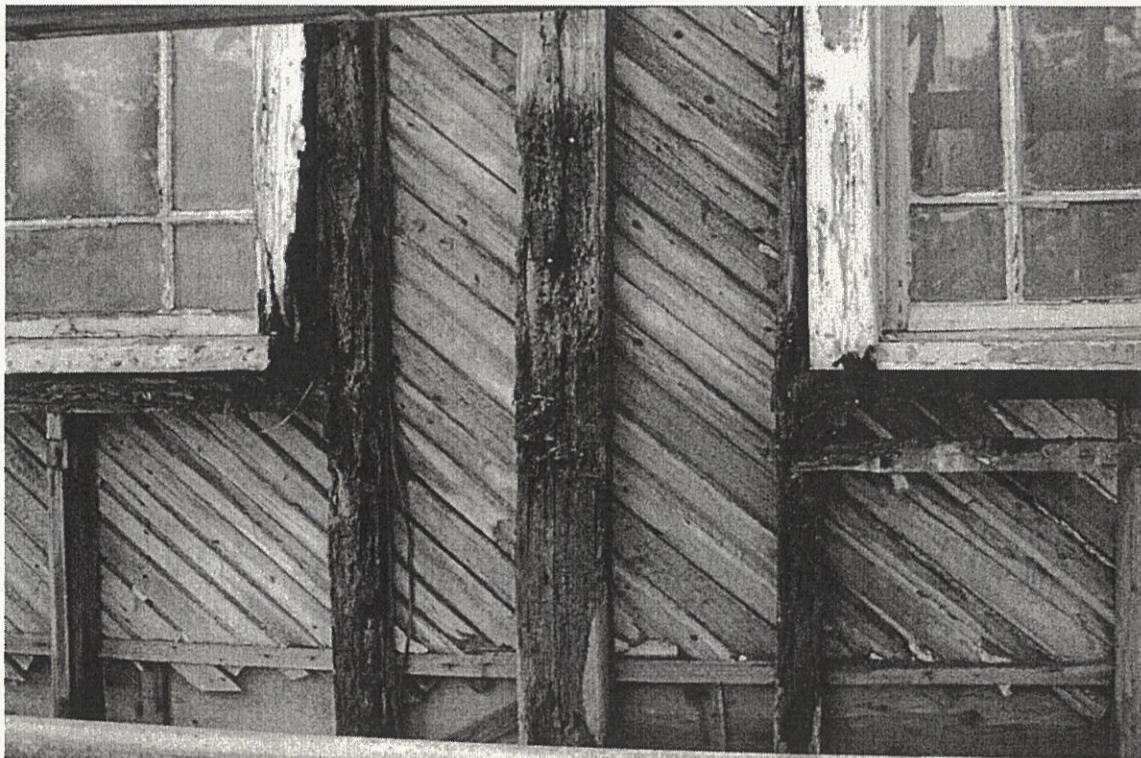
平成 14（2002）年度改修工事前
